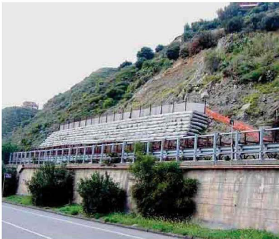
LA "TRINCEA TERRAZZATA" REALIZZATA PER CONSOLIDARE IL PIEDE DELLA FRANA SULL'A18 IN LOCALITÀ S. FILIPPO A LETOJANNI
