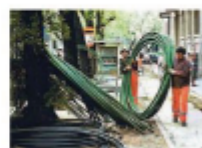
Posa di cavi per banda larga
